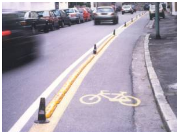
Fig.9 Separazione tra corsia dedicata ai veicoli motorizzati e corsia ciclabile tramite dispositivo del tipo "occhi di gatto"
